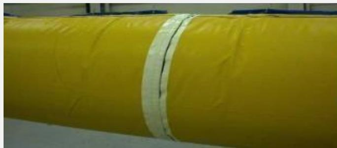
Instalación de unión Velcro (mantener Unión Velcro sellada tenso y pegar velcro de arriba hacia abajo)
