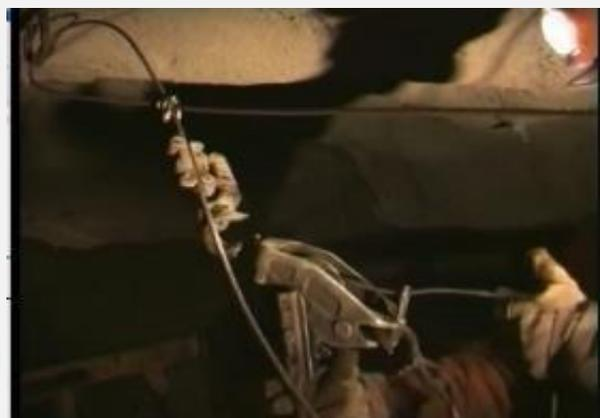
Instalar perno cáncamo de anclaje hacia la frente Instalar y tensar cable mensajero (puntero)
