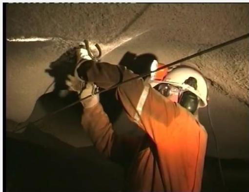
Instalar pernos cáncamos cada 5 metros Fijar con alambre N° 12 desde el cáncamo Hasta el cable mensajero manteniendo el cable horizontal
